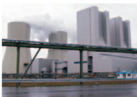
Kraftwerke Power Plants
